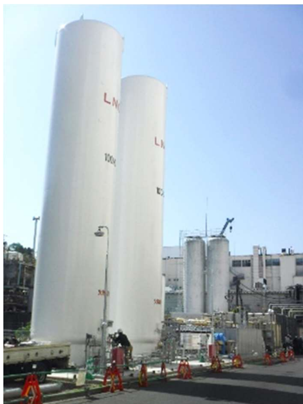
ガス貯蔵施設の建設工事の様子
