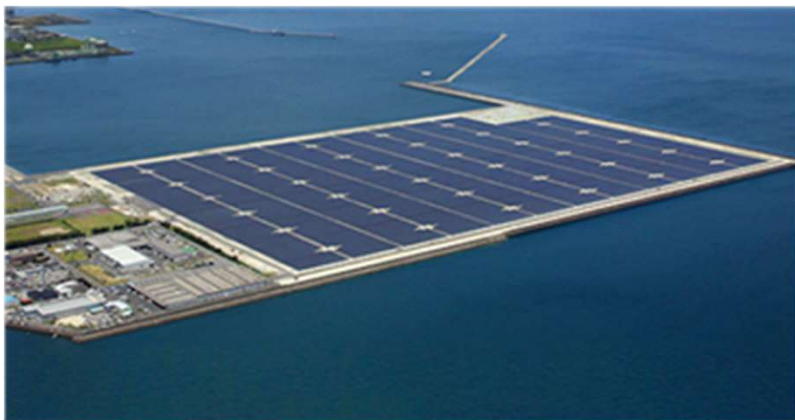
鹿児島七ツ島メガソーラー発電所
