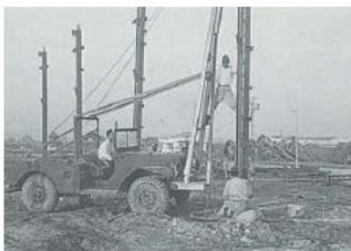
社員が運転するジープで鉄骨を吊上げている
