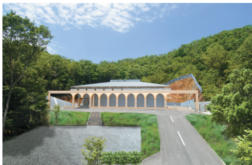
固い岩盤の上に立つ本社工場
